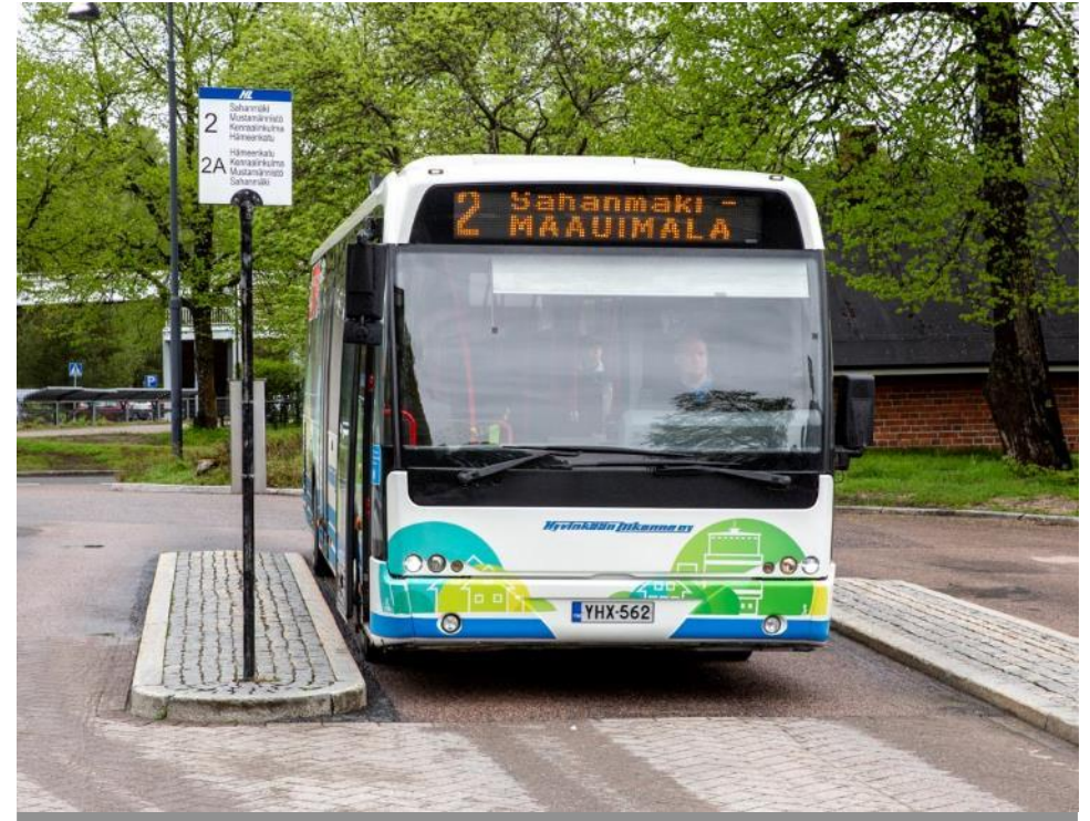
Kuva: Rautatieaseman nykyisen terminaalien lähtölaituri. Laiturin leveys ei ole riittävä esim. pyörätuolia käyttävän matkustajan käytettäväksi
